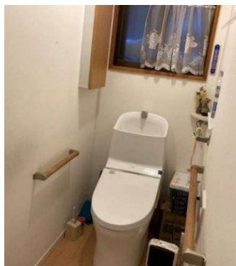
手すりの設置例（左写真：戸建住宅、中写真：賃貸住宅、右写真：分譲住宅）
