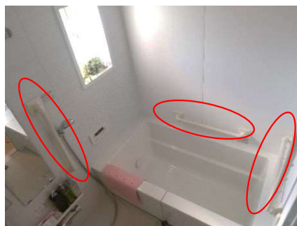
浴室内（3 か所）の手すり設置事例（分譲住宅）
